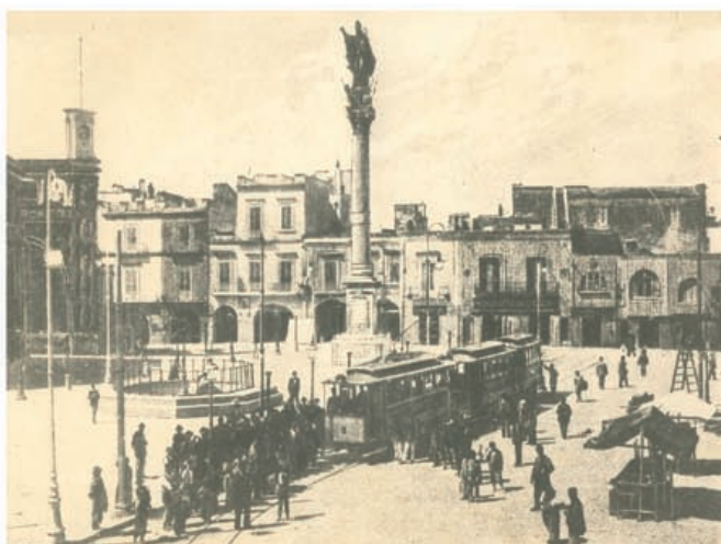
Il tram elettrico a Piazza S. Oronzo
