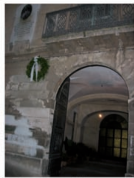
Ingresso della casa in Via Regina Isabella
